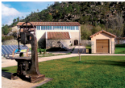
Casa de la Reserva Natural del Valle de Iruelas "Las Cruceiras"
